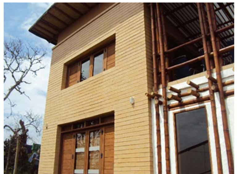
Figura 9. Fachada en BSC, bahareque y guadua
