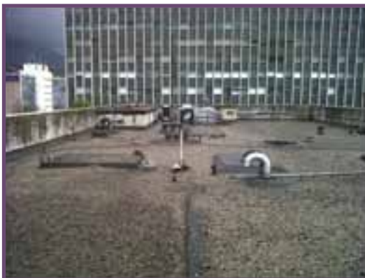
Terraza antes de la intervención
