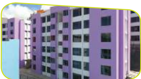
Conjunto Residencial San Sebastián Pasto - Nariño 400 viviendas
