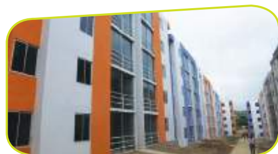
Ciudadela los Estoraques Cúcuta - Norte de Santander 900 viviendas
