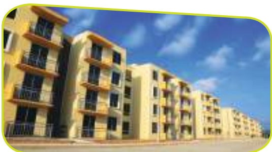
Villas de San Pablo Barranquilla - Atlántico 832 viviendas
