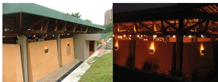
Figura 1. Muros en tapia, en el restaurante de la Universidad Adventista de Colombia.
