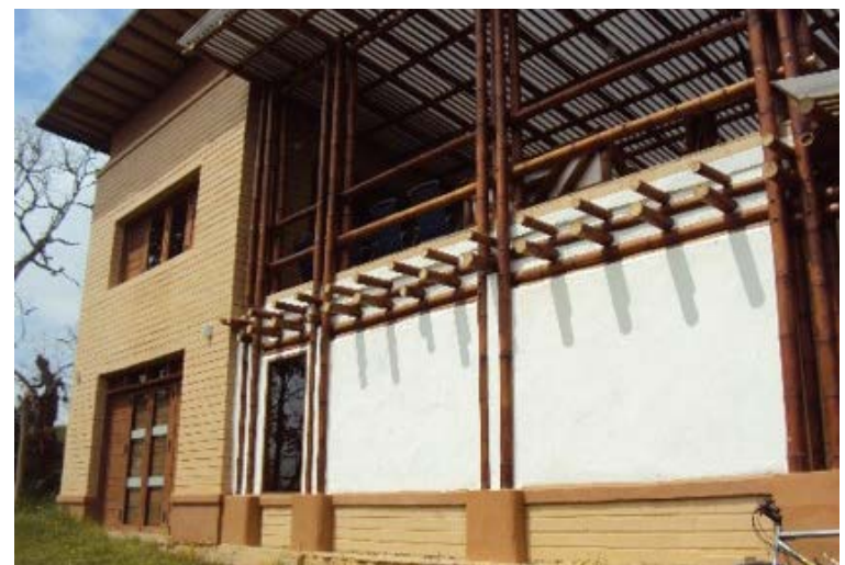
Figura 6. BSC tipo lego o machihembrado
