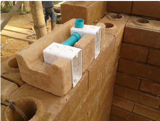
Figura 6. BSC tipo lego o machihembrado
